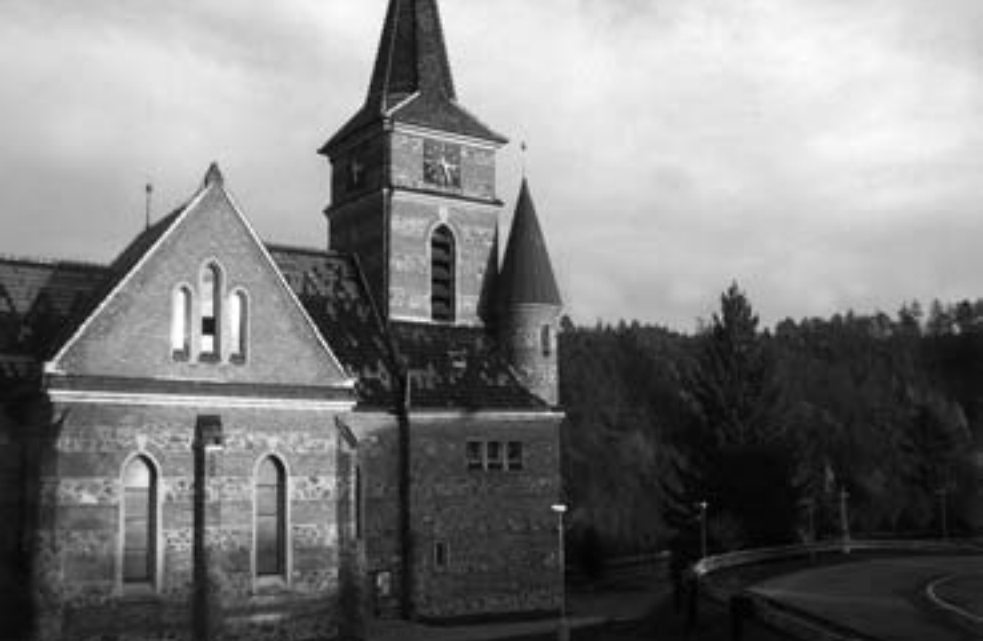
Obnovený kostel v Bílovcích
