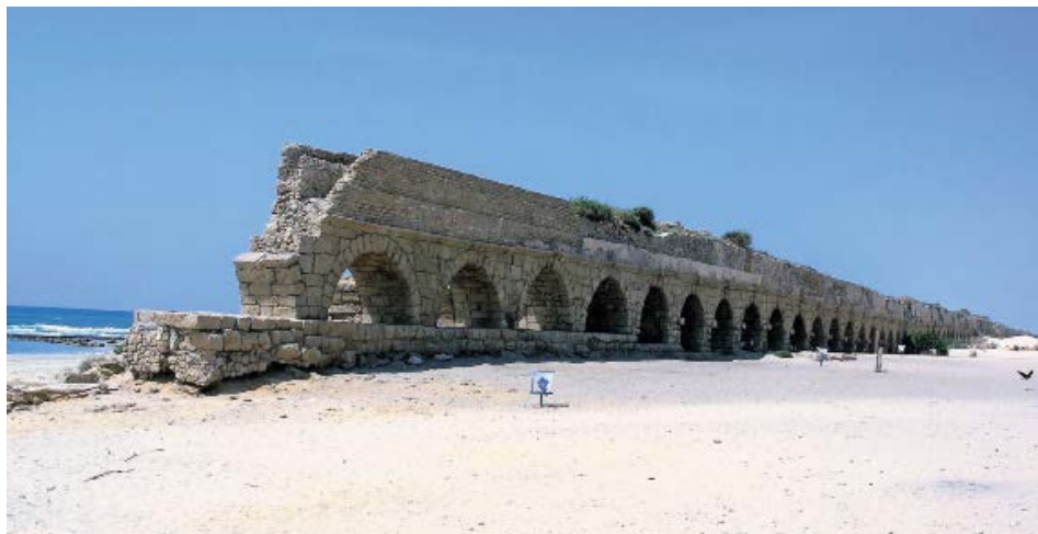
Zbytky aquaduktu v židovském městě Cesarea, který postavil Herodes, je ukázkou globalizace tehdejšího světa. Zcela identické konstrukční prvky najdeme po celém Středomoří. Izrael, 2014.
