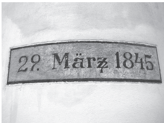
Nápis na jednom z rohů přestavěného Zlomkovského mlýna zřejmě odkazuje k hladině vody při povodni dne 29. března 1845
