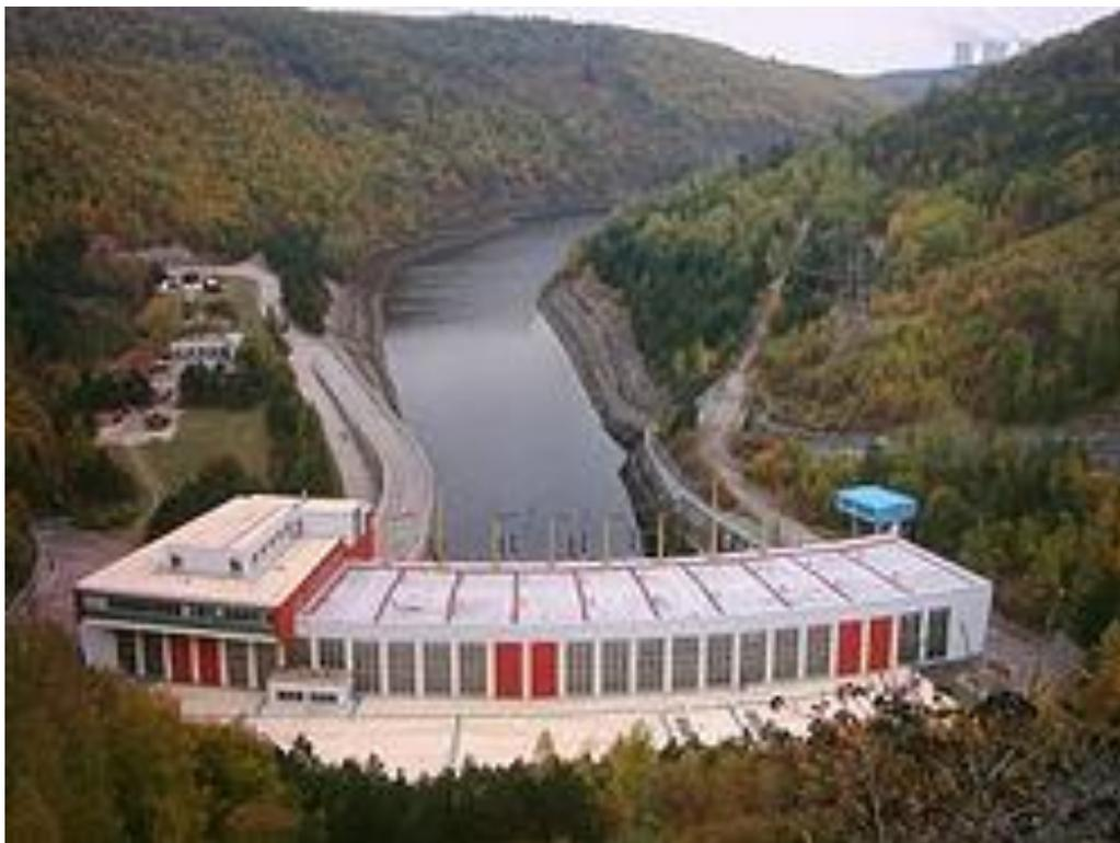
Совместно с водохранилищем Мохельно, Далешницкая насосная электростанция мощностью  $4 \times 120$  МВт расположена под плотиной Далешнице.
