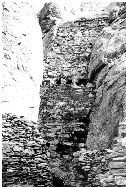
Obr. 5a, 5b. Vyzdívka severní strany východní stěny budovy č. 1 s brankou a s trámovými lůžky. 5a: pohled od západu. 5b: 1 – skalní masiv; 2 – kapsy pro uložení stropních a střešních trámů; 3 – body pětmetrové a metrové čtvercové sítě. Abb. 5a, 5b. Ausmauerung der Nordseite der Ostwand von Gebäude Nr. 1 mit Tor und Balkenlager. 5a: Blick von Westen. 5b: 1 – Felsenmassiv; 2 – Taschen zur Lagerung der Decken- und Dachbalken; 3 – Punkte des Fünf-Meter- und Meterrasters.
