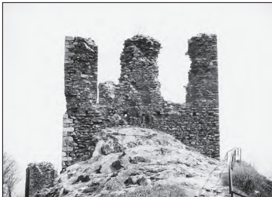
Obr. 1. Andělská Hora. Obytná věž na nejvyšším bodě staveniště v pohledu od západu
