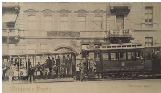
Tramvajová zastávka ve Škrátově ulici pod Demínkou
