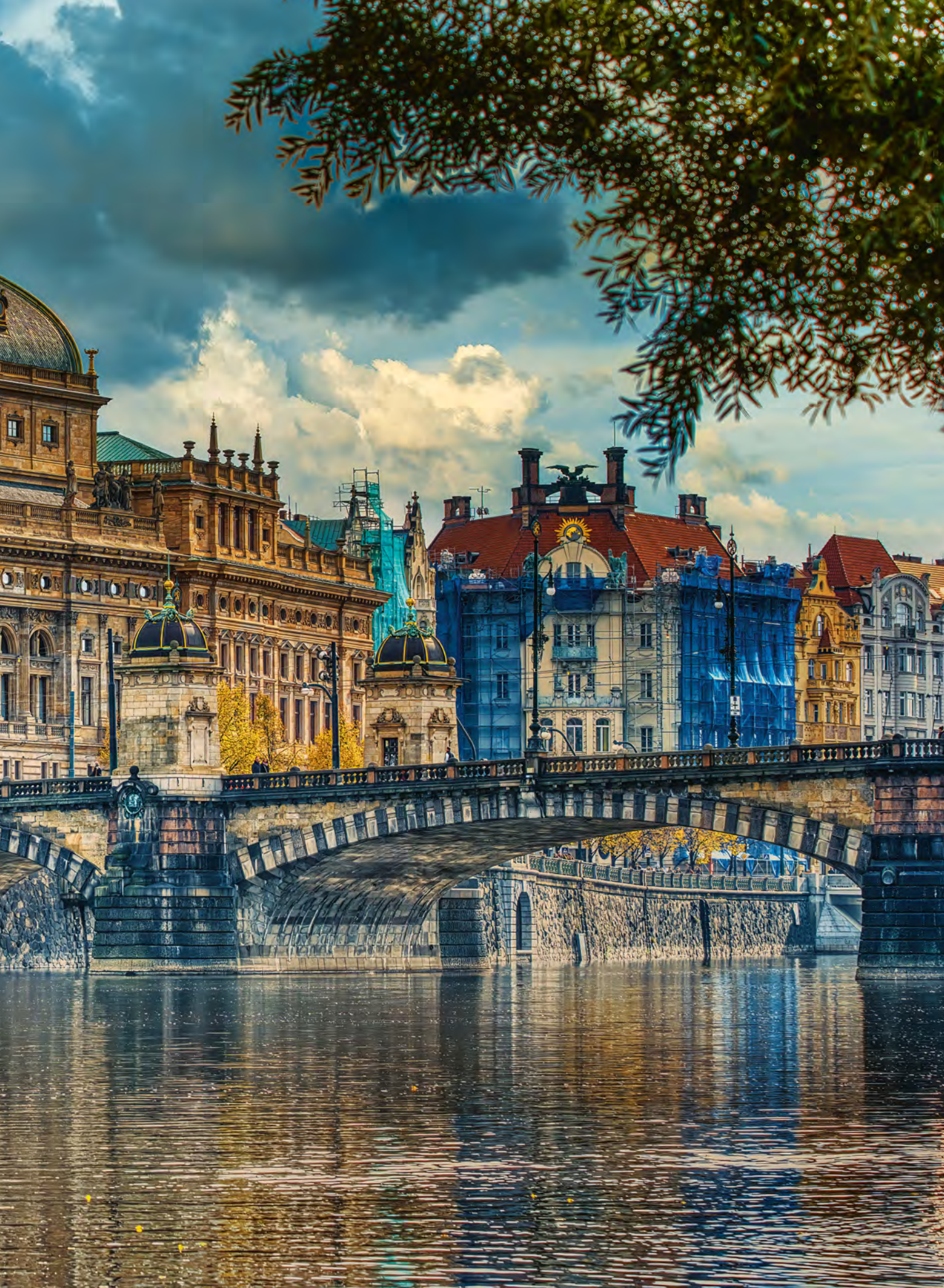
Národní divadlo sídlí v novorenesanční budově od Josefa Zítka. Je to jedna z nejvýznamnějších staveb v zemi. Vyrostla v letech 1868 až 1883 The National Theatre is housed in a neo-Renaissance building by Josef Zítka. One of the most significant buildings in the country was betw. 1868–1883
