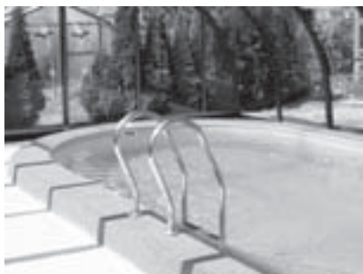
Obr. 11 | Nerezové závěsné schodiště
