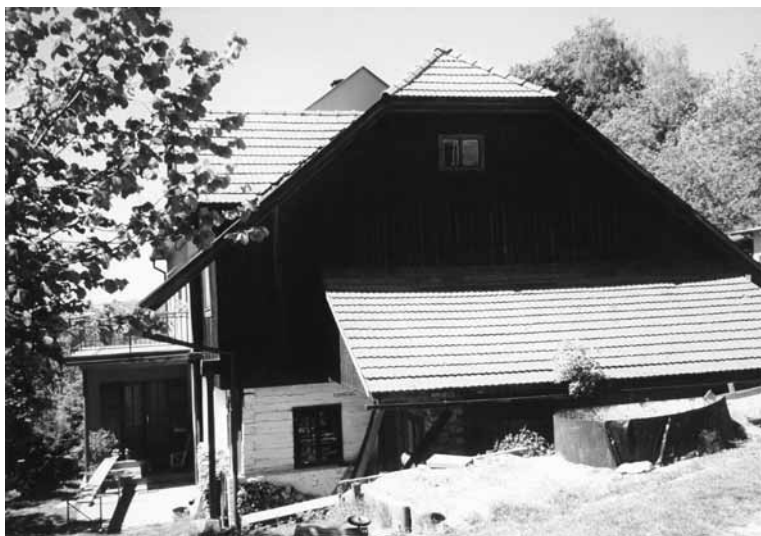
Rodný dům bezrukého Frantíka v Jamném nad Orlicí; přední část původní, zadní nová přestavba.
