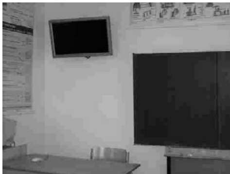
Obrázek 1.2: Umístění 32" monitoru vedle tabule v učebně pro 30 žáků. Při instalaci je třeba znemožnit poškození monitoru pohybující se tabulí, v tomto případě zarážkou v levém pantu tabule.
